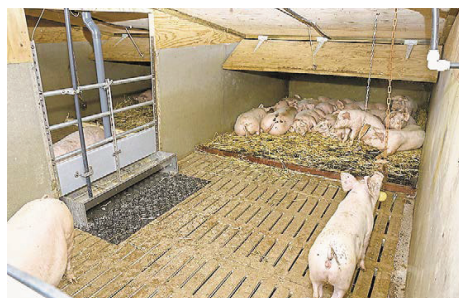
Blick ins Innere: Bis zu 50 % Spalten sind zulässig. Eine Stufe hilft, dass der Liegebereich trocken bleibt.
