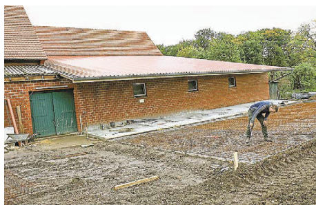
Direkt hinterm Wohnhaus entsteht der Stall für die Vormastschweine – mit Fußbodenheizung und Auslauf.
